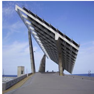
Figura 1.2: Pergola solare installata a Barcellona
